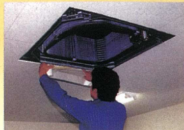
養生マスカーをエアコン本体周囲に巻く。
